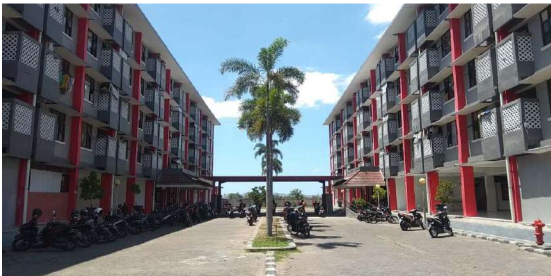
Gambar 25 Pembangunan Rumah Susun Sederahan Sewa (Rusunawa) Kota Blitar (Sumber : Website Kota Blitar )
