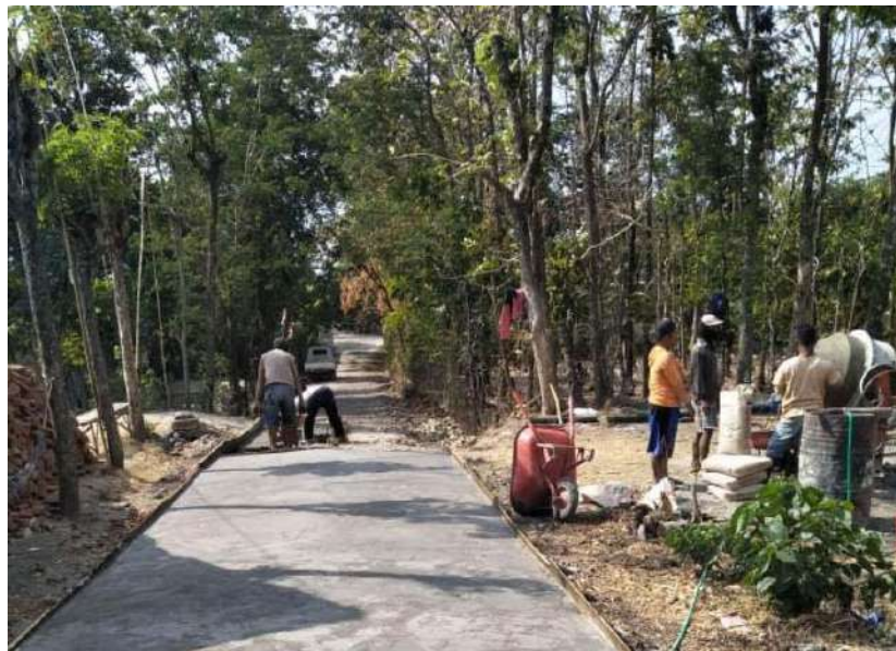
Gambar 11 Pembangunan jalan yang didanai dari Dana Desa (sumber : www.ngawikab.go.id )
