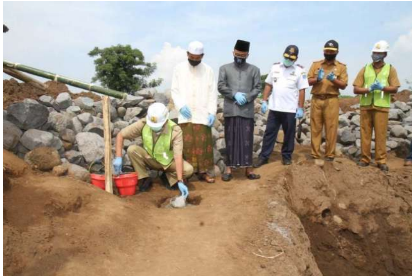
Gambar 37 Wali Kota Probolinggo peletakan batu pertama pembangunan RS Baru Kota Probolinggo (Sumber : Website Kota Probolinggo)
