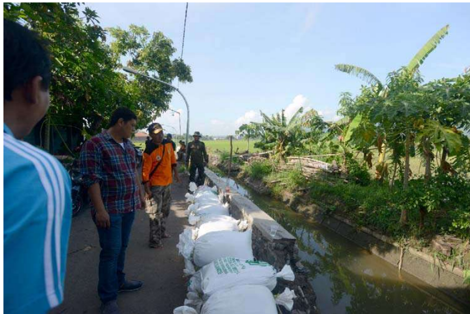
Gambar 30 Pembangunan Tanggul Kelurahan Ngampel di Kota Kediri (Sumber : Website Kota Kediri)
