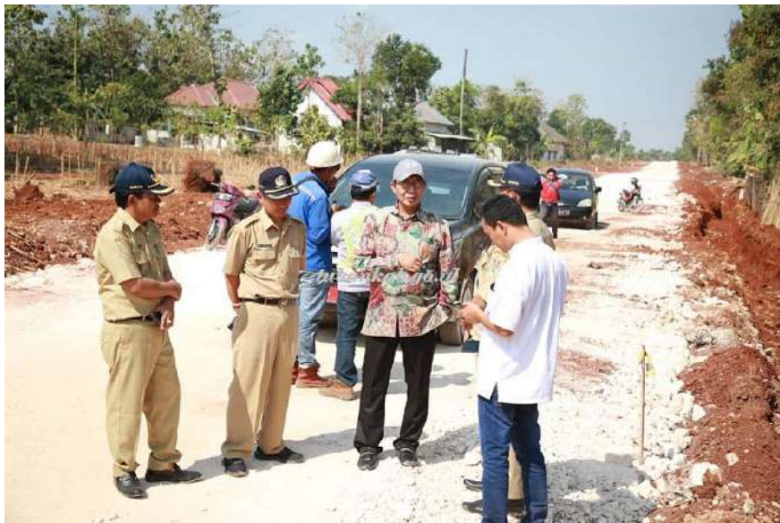
Gambar 17 Bupati meninjau pembangunan Jalur Lingkar Selatan Tuban (sumber: www.tubankab.go.id )
