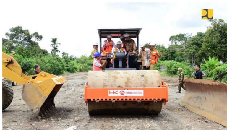
Gambar 14 Dokumentasi pencahangan pembangunan Tol Simpang Indralaya-Muara Enim-Lubuk Linggau (sumber: Independensi.com)
