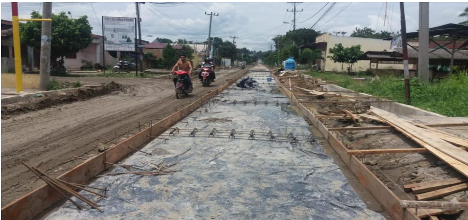
Gambar 31. Pembangunan rabat beton dan parit pasangan di nagari parbalongan Simalungun (Sumber: Dok. Pemkab Simalungun)
